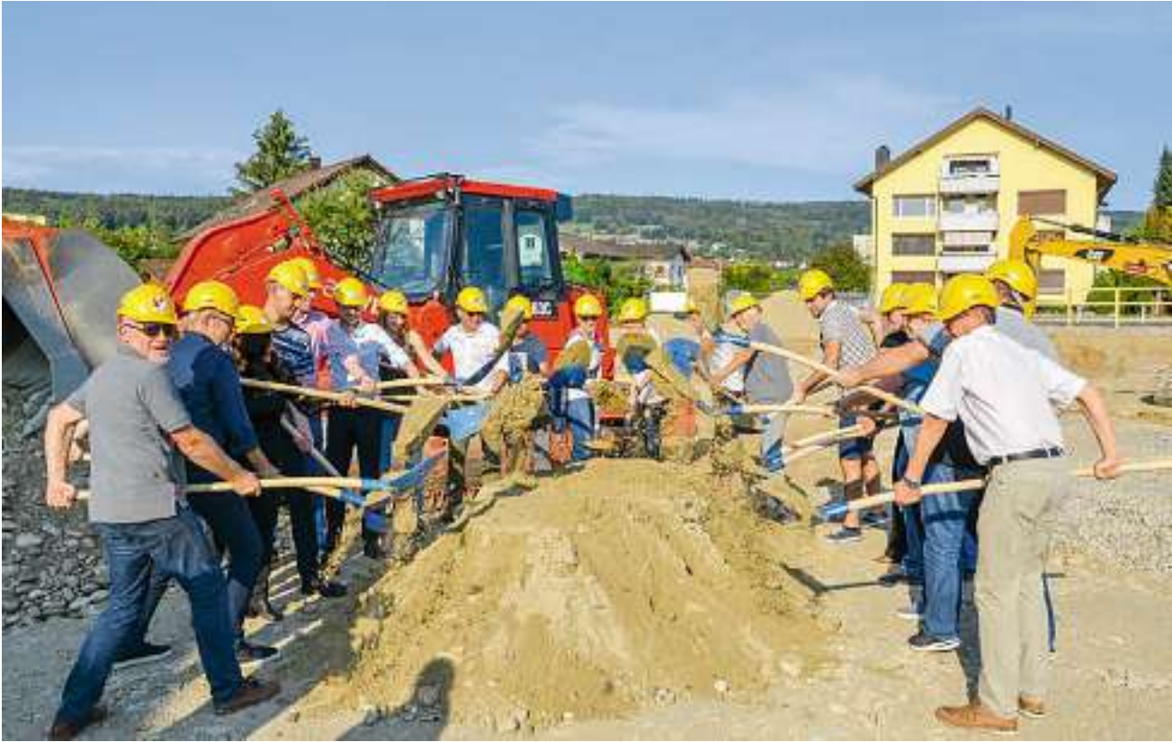
Und los gehts: Anschliessend an den Spatenstich wurde der Baustart mit einem Apéro gefeiert
